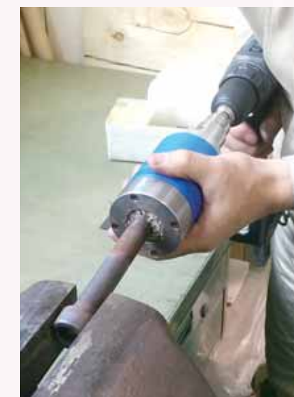
ボルトのサビを現場でスピード除去
